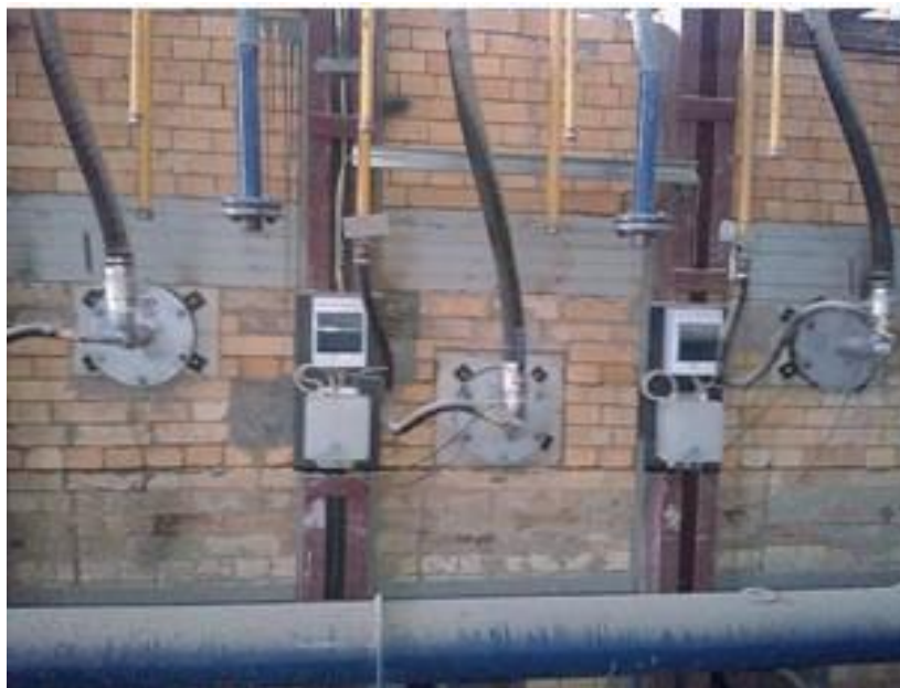
Вид печі збоку з пальниками і блоками управління
